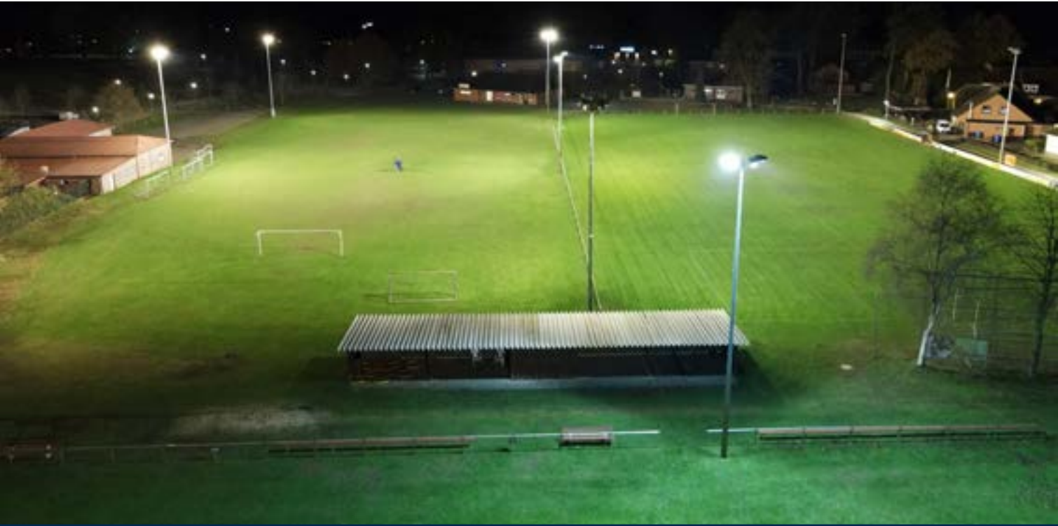
2023 Sportplätze in Heidenau vor der Erneuerung der Flutlichtanlage
