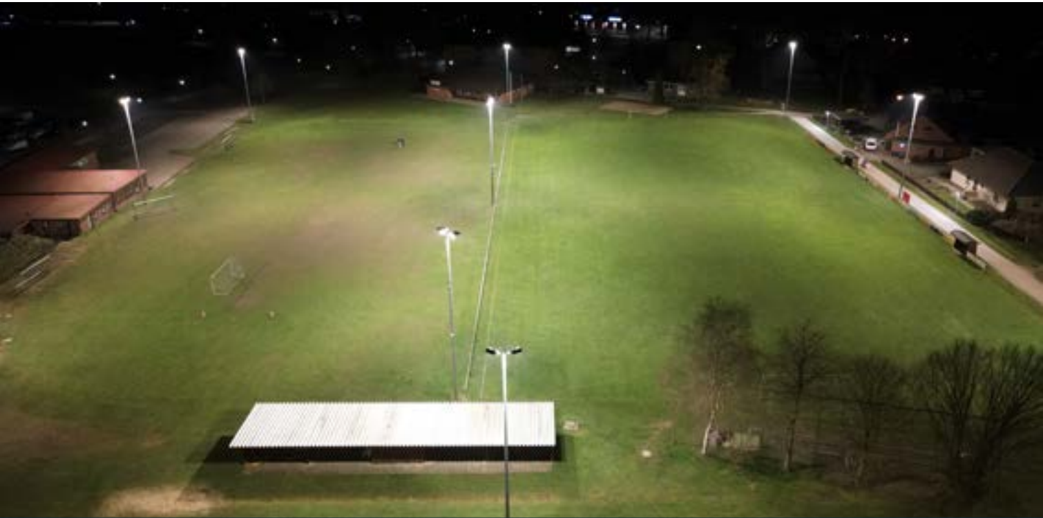
2023 Sportplätze in Heidenau nach der Erneuerung der Flutlichtanlage
