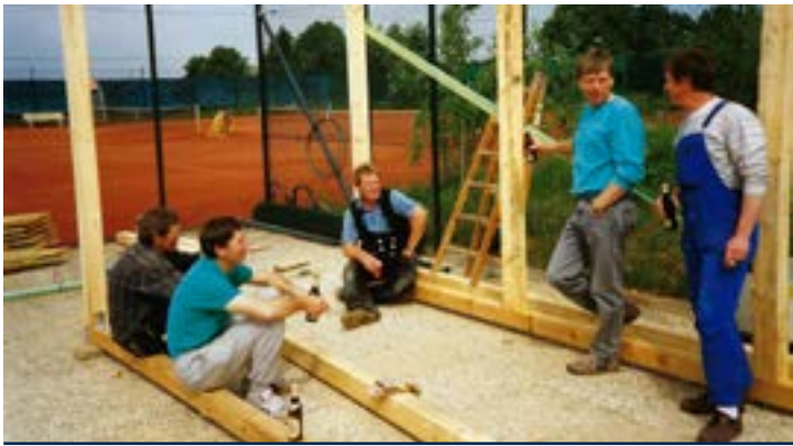
1994 Bau des Unterstandes für die Tennishütte
